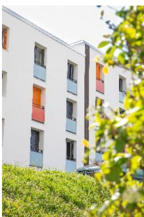
■ Rue Molière : 18 logements pour 449 200 € ■ Rue Racine : 27 logements pour 673 800 €
