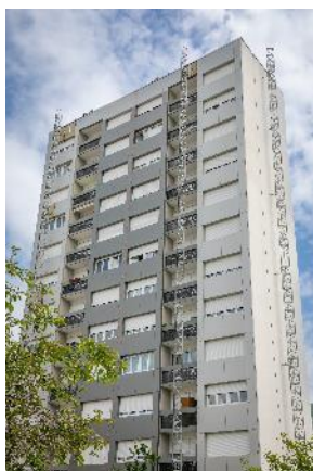
■ Rue Dunant : 98 logements pour 3 281 432 €
